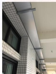
骨幹網路更新整合於鋁製線槽中
